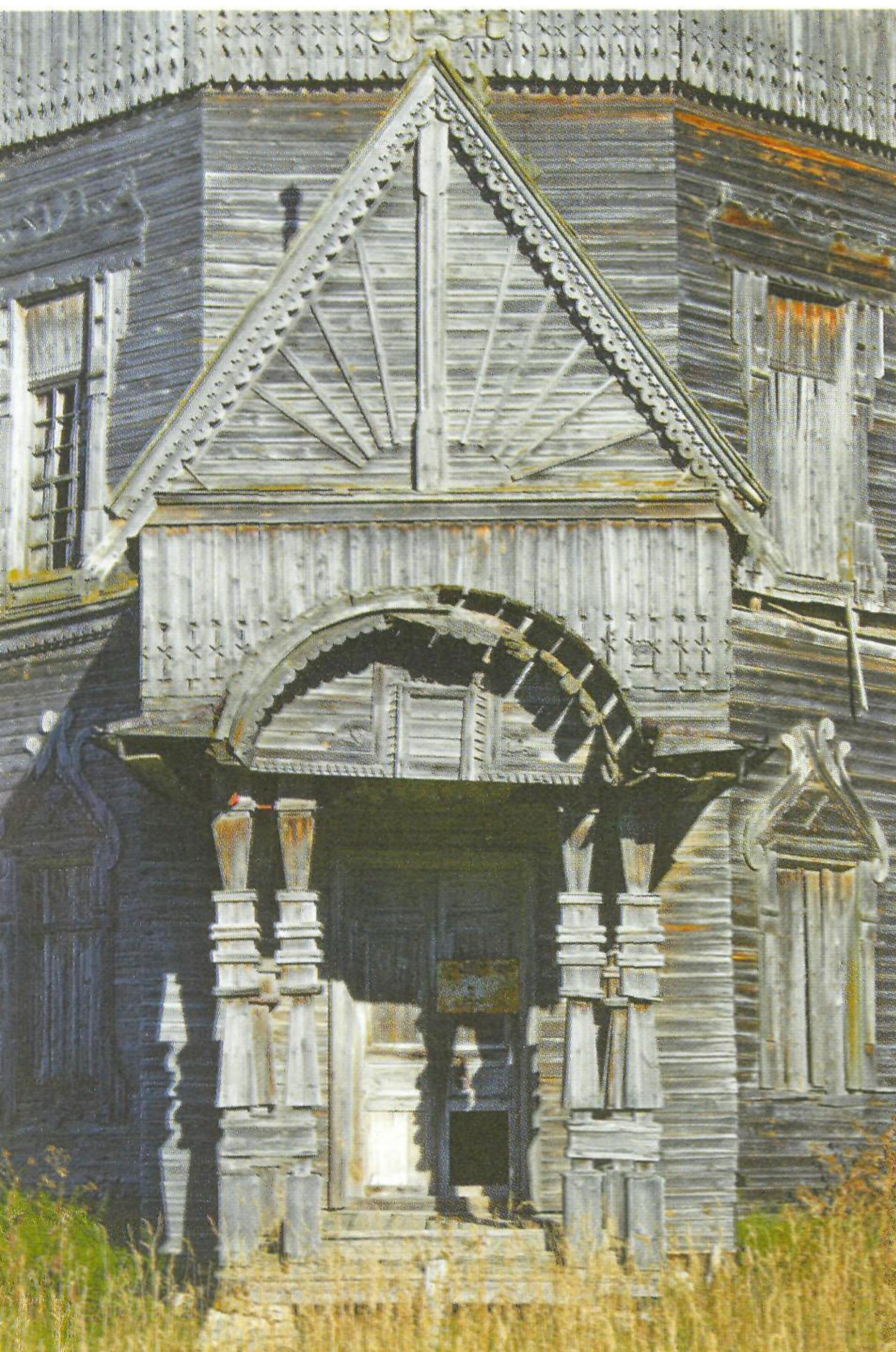
следы строительной истории памятника. В процессе обследования выявлено много следов различных утраченных элементов. О переборке сруба напоминает маркировка бревен, сделанная красным мелом, она идет сверху вниз. Габариты основного сруба после переборки в целом не изменились. По обмерному чертежу видно, что очертания плана немного неправильные, прирубы разной величины.
