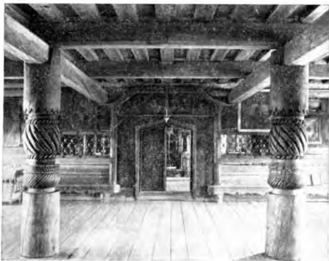
Рис. 23. Трапезная Петропавловской церкви села Пучуги на Северной Двине. 1698 г. Фото В. М. Владимирова. 1900-е годы. (ГНИМА)
